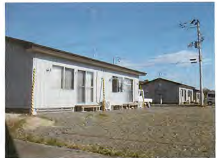
●いわき市の仮設住宅
