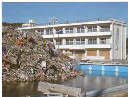
●津波にあった豊間地区 豊間中学校の運動場は瓦礫の山
