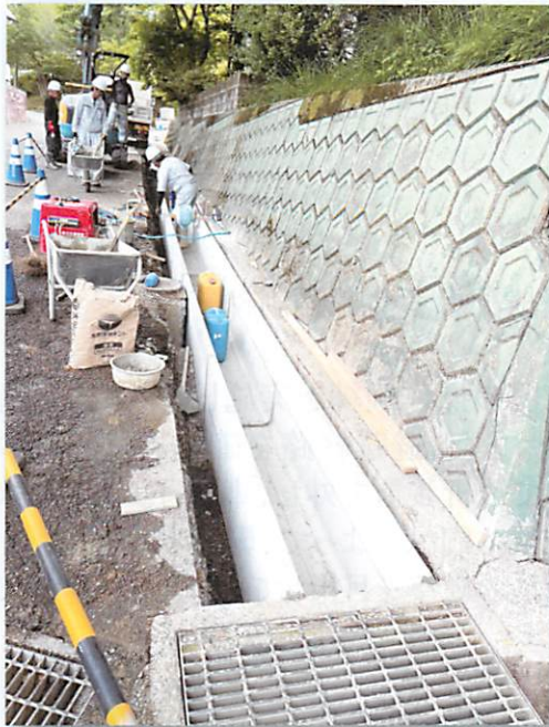
排水構造物工事の様子
