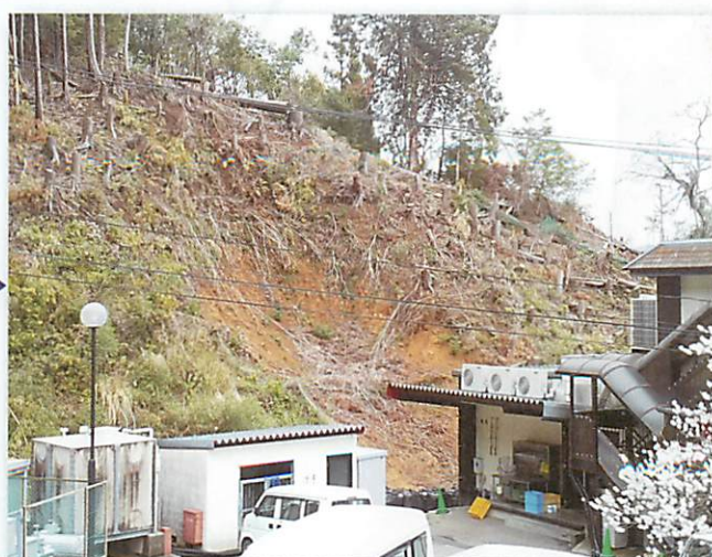
施行前(伐採された状態)
