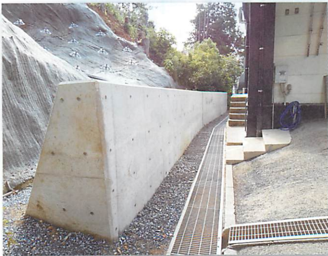
擁壁の設置直後
